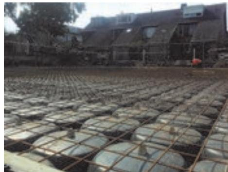
armature prête pour couverture en béton
