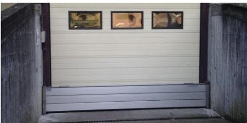
**MURO™ | BARRAGE ANTI-CRUE MODULAIRE**
